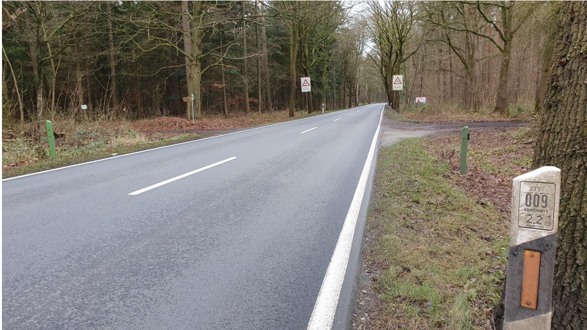
Abbildung 22: Übergang zum Waldabschnitt in der Ausstattungsstrecke an der L 8 (Quelle: LSBB)
