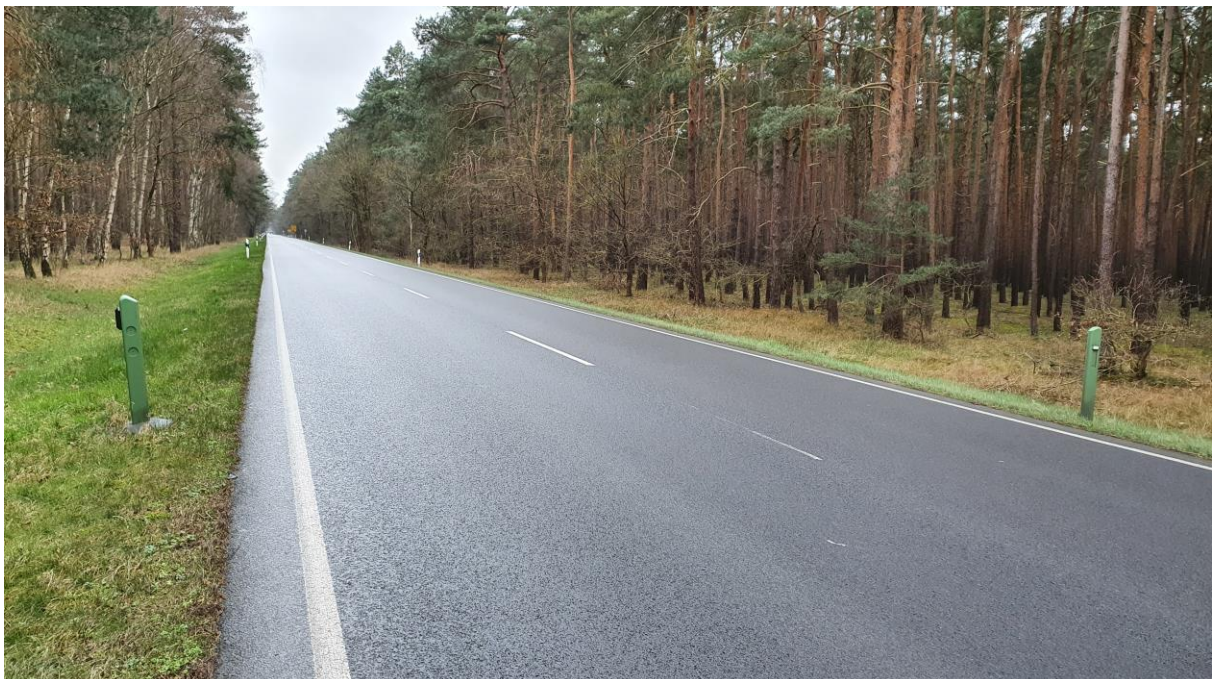
Abbildung 9: Platzierung der Wildwarngeräte an beiden Fahrbahnrandern an der B 107 am Ende der Ausstattungsstrecke (Wildwarner 0,5 m vom Fahrbahnrand entfernt) (Quelle: LSBB)
