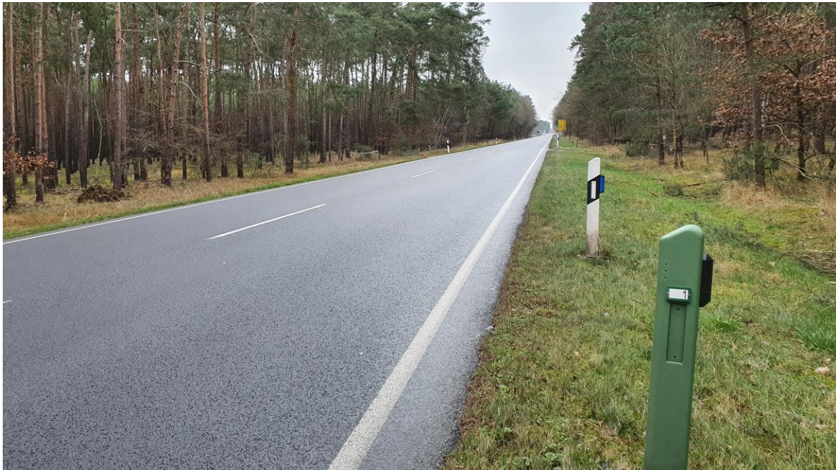
Abbildung 8: Beginn der Ausstattungsstrecke an der B 107 in Richtung Kletz (Quelle: LSBB)
