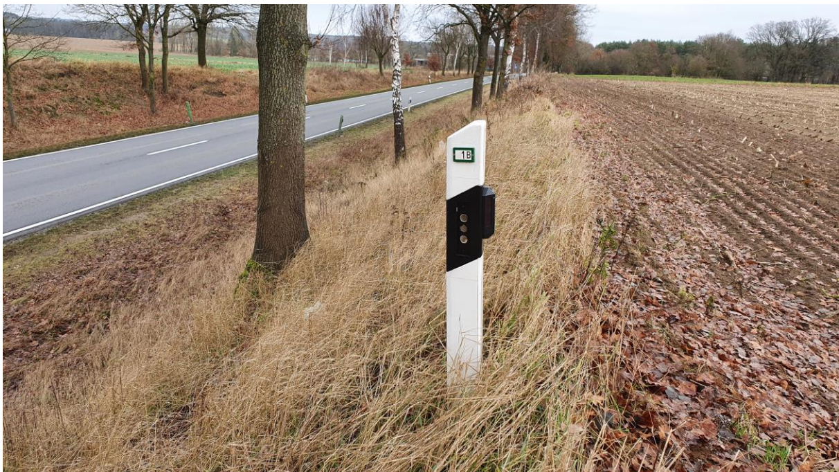
Abbildung 21: Aufstellung zusätzlicher Wildwarngeräte an weißen Trägerleitpfosten an der Oberkante des Einschnitts (Quelle: LSBB)
