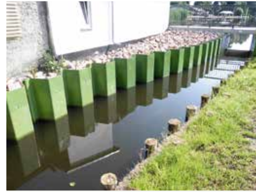
Sanierter Zulaufgraben vom Libbesdorfer Landgraben zum Mosigkauer Bad Foto: Dieter Klein (cproject ingenieure gmbh)
